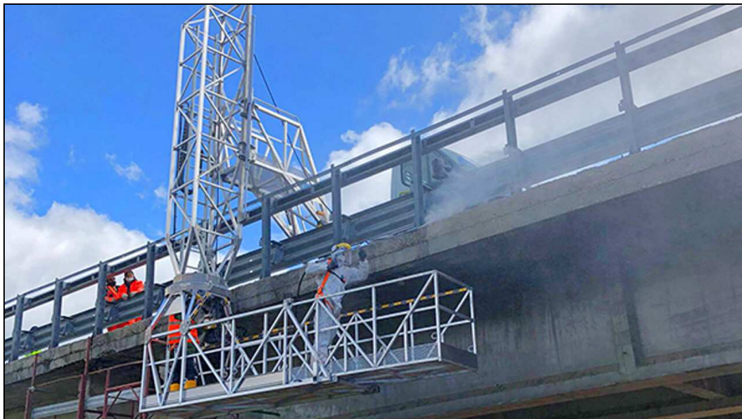
Tipologia della piattaforma by-bredge in utilizzo su "parte alta"
