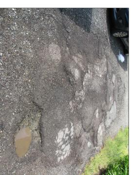
Area oggetto di intervento di messa in sicurezza mediante stesa di nuovo tappeto di conglomerato bituminoso per strato di usura
